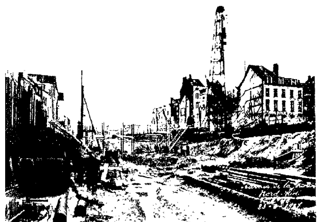
LES Puits de DRAINAGE DE DRAINEERPUTTEN
