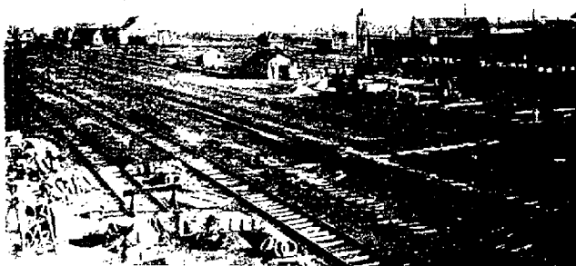
VUE GENERALE DU NOUVEAU FAISCEAU DE GARAGE
