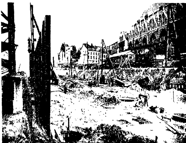
LE RIDEAU DE PALPLANCHES DE DAMWAND
