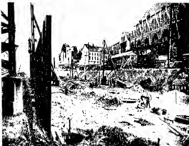
LE RIDEAU DE PALPLANCHES DE DAMWAND
