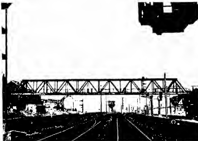
DEMONTAGE DE LA PASSERELLE DE LA RUE DES PALAIS
