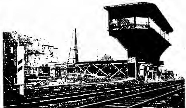
CABINE III ET CHEMIN DE ROULEMENT POUR SON DEPLACEMENT
